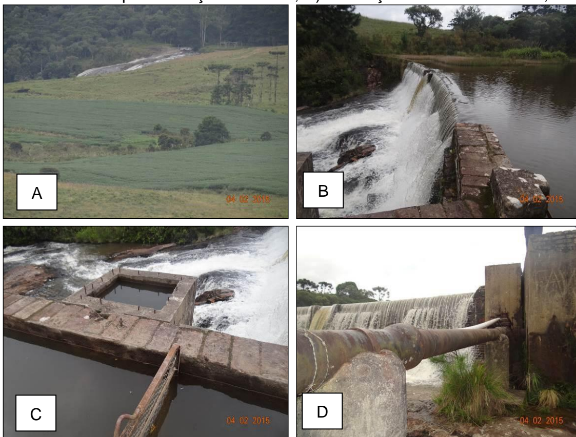
Figura 10 – A) Plantio de soja em APA; B) Captação do Rio Turvo; C) Caixa de Alvenaria com tela para remoção de folhas; D) Tubulações de saída da caixa;
