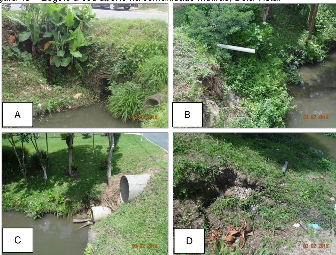
Figura 49 – Esgoto a céu aberto na comunidade Mutirão, Bela Vista.
