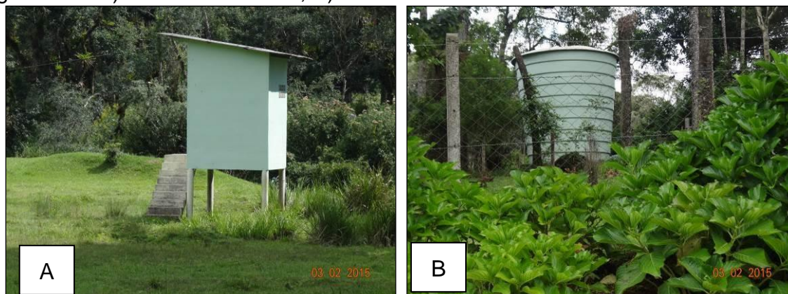
Figura 17 – A) Casa de Química; B) Reservatório 20 m 3 .
