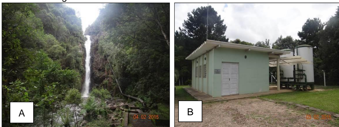
Figura 11 - A) Rede de captação até a ETA, margeando cascata; B) Estação de Tratamento de Água Central.
