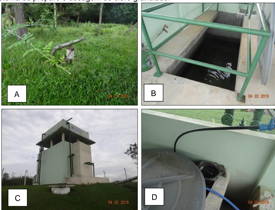
Figura 20 – A) Poço artesiano; B) Sistema de Filtro Lento; C) ETA Fragosos; D) Sistema de preparo e dosagem de cloro granulado.
