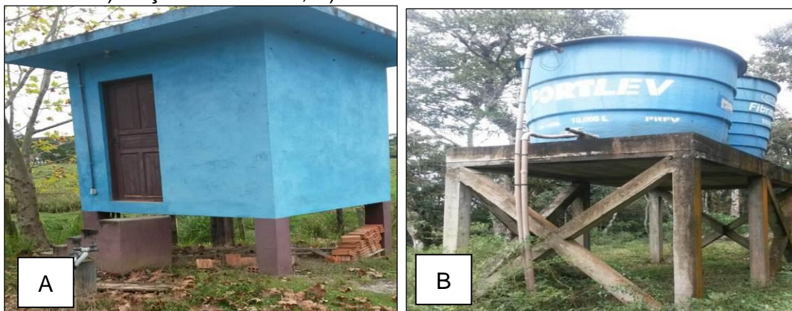
Figura 27 – A) Poço subterrâneo; B) Reservatórios de 20 e 10 m 3 .
