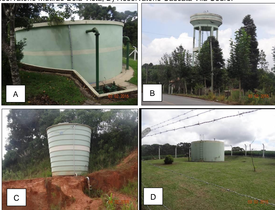
Figura 13 – A) Reservatório ETA Central; B) Reservatório Vila Scheide; C) Reservatório Mutirão Bela Vista; D) Reservatório Cascata Vila Cedro.
