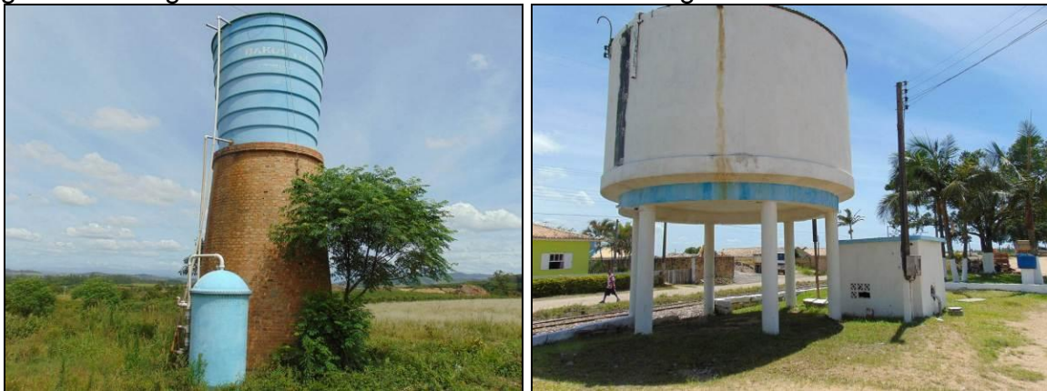
Figura 5 – Imagens do sistema de abastecimento de água.
