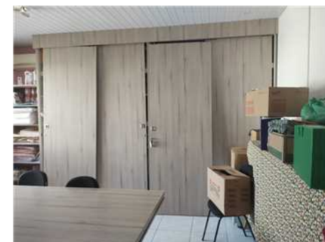
AM5 existente - Manutenção de armário - Arrumar as portas, fazer reforço.
