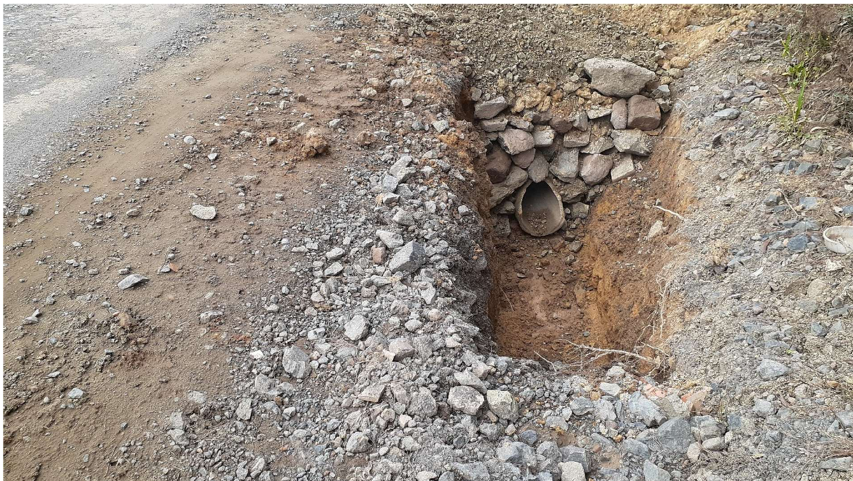
Foto 4 - Rua Santo Antônio (trecho entre SC 418 e rua Carolina Kotovics)
