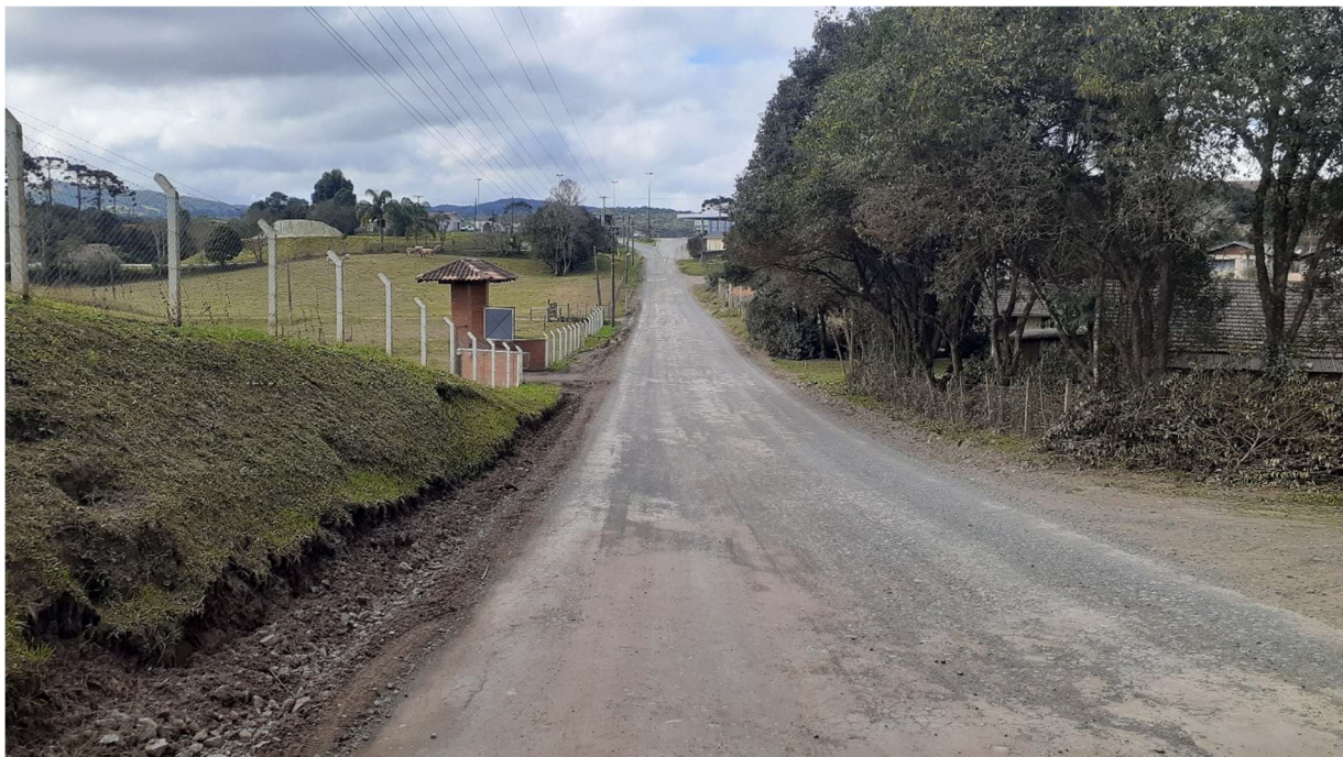
Foto 3 - Rua Santo Antônio (trecho entre SC 418 e rua Carolina Kotovics)
