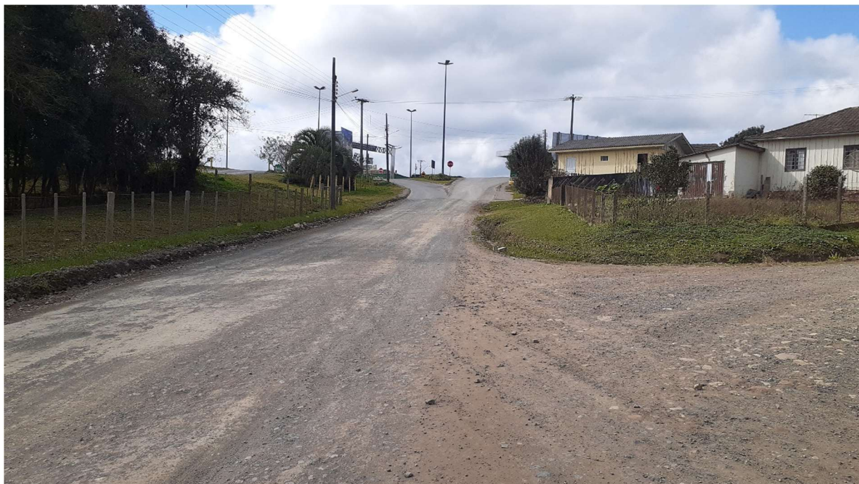
Foto 1 - rua Santo Antônio (trecho entre SC 418 e rua Carolina Kotovics)
