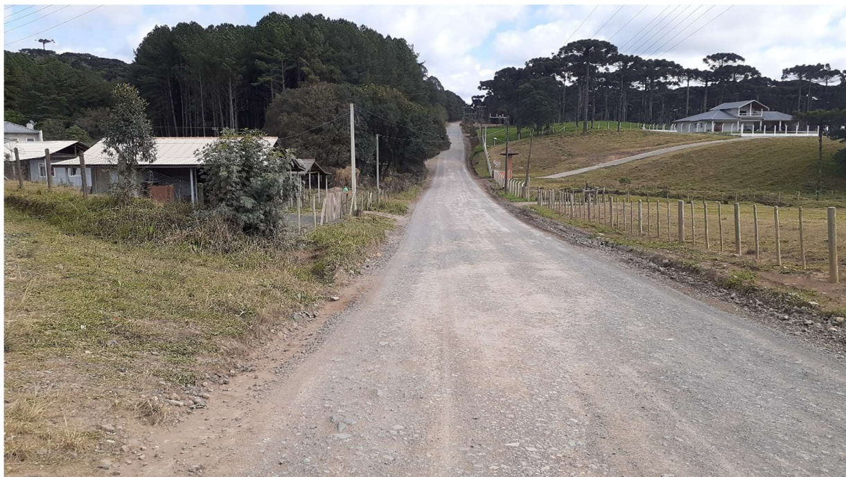
Foto 2 - Rua Santo Antônio (trecho entre SC 418 e rua Carolina Kotovics)
