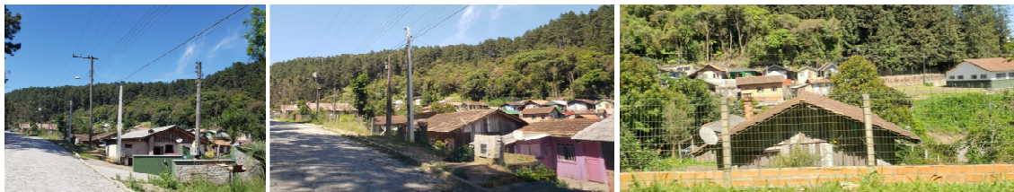
Figura 08 – Casas próximas a futura edificação, fazem parte da ZRO. Acervo da autora.
