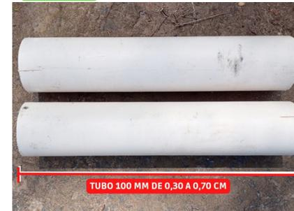
O tubo deve ser cortado na medida de 0,30 a 0,70 cm, conforme altura da mureta.
