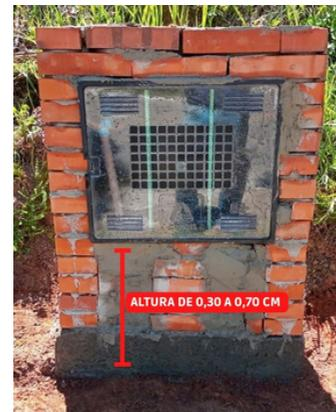
Erguer a parede de tijolos conforme as medidas exigidas e colocar calços dentro da caixa para evitar baixar com o peso dos tijolos (conforme imagem).
