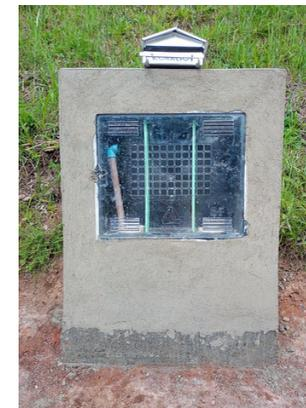
Rebocar a parede e fixar uma caixa de correspondência para que a fatura possa ser deixada no local.
