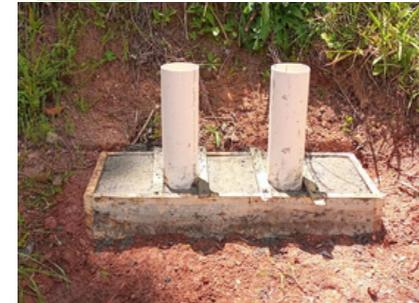
Concretar a base, lembrando que os tubos de 100mm devem estar com as entradas livres para entrada e saída de água.
