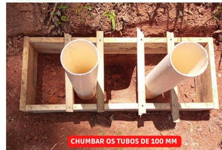
Fazer uma caixaria para a base, colocando os dois tubos de 100mm obedecendo as medidas.
